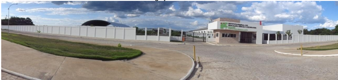
Figura 5. Campus do Instituto Federal de Educação, Ciência e Tecnologia Baiano (Ifbaiano) no Perímetro de Irrigação Formoso
