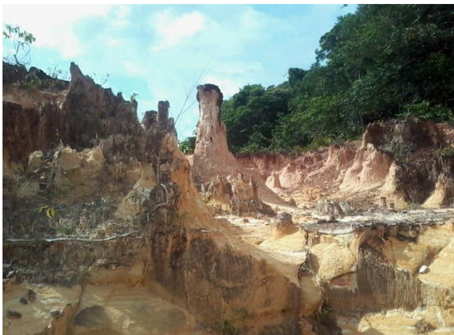
Figura 7. Presença de voçoroca na Colônia.
