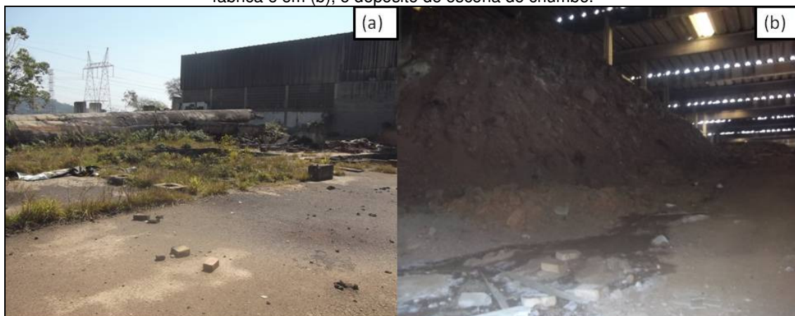
Figura 1. Caçapava, área da antiga Faé, Indústria e Comércio de Metais. Em (a), a estrutura em ruína da fábrica e em (b), o depósito de escória de chumbo.
