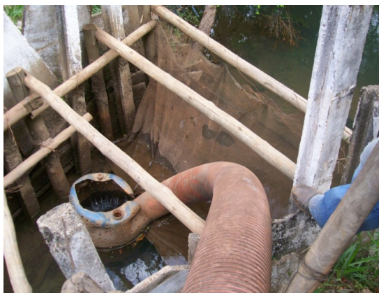
Figura 4: Captação de água direta no córrego Lajeado que abastece um pivô central – 2011.
