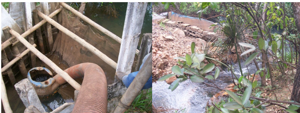
Figura 8: Degradação ambiental na área de captação direta de água - 2011
