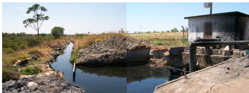
Figura 7: Dreno responsável por concentrar a água localizada em vereda para captação.
