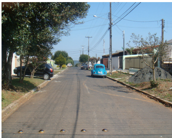
Foto 3: Pavimentação asfáltica e passeios
