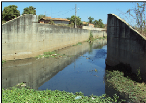
Foto 3: Canal de esgoto.
