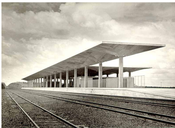
Figura 2 – 3ª Estação Ferroviária de Uberlândia, inaugurada em março de 1970
