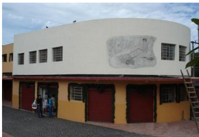
Figura 5- Uberlândia- MG – Mercado Municipal durante processo de restauração Fonte: Acervo Prefeitura de Uberlândia
