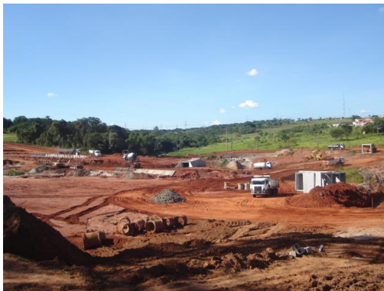
Foto 6: Obras no fundo de vale da construção da Avenida Nações Norte.
