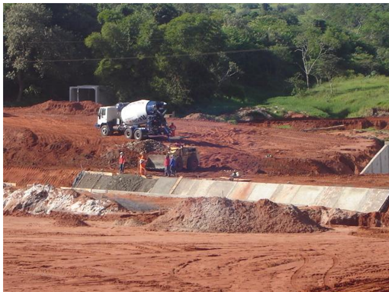
Foto 7: Canalização do Córrego do Castelo.
