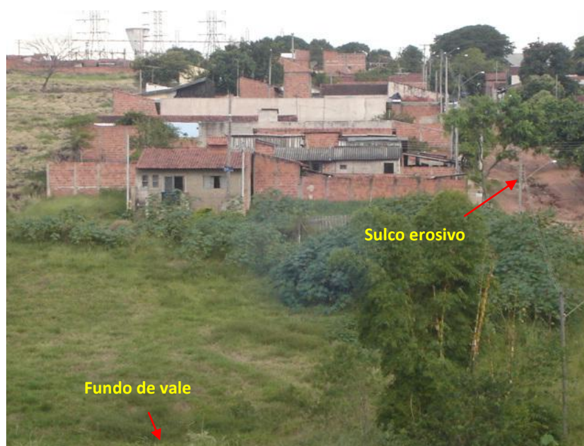
Foto 2: No canto superior direito, sulcos erosivos nas ruas não pavimentadas provocados pelas enxurradas das águas pluviais
