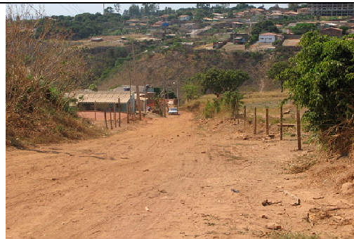
Figura 7: Ruas sem asfaltamento e com intensa declividade.
