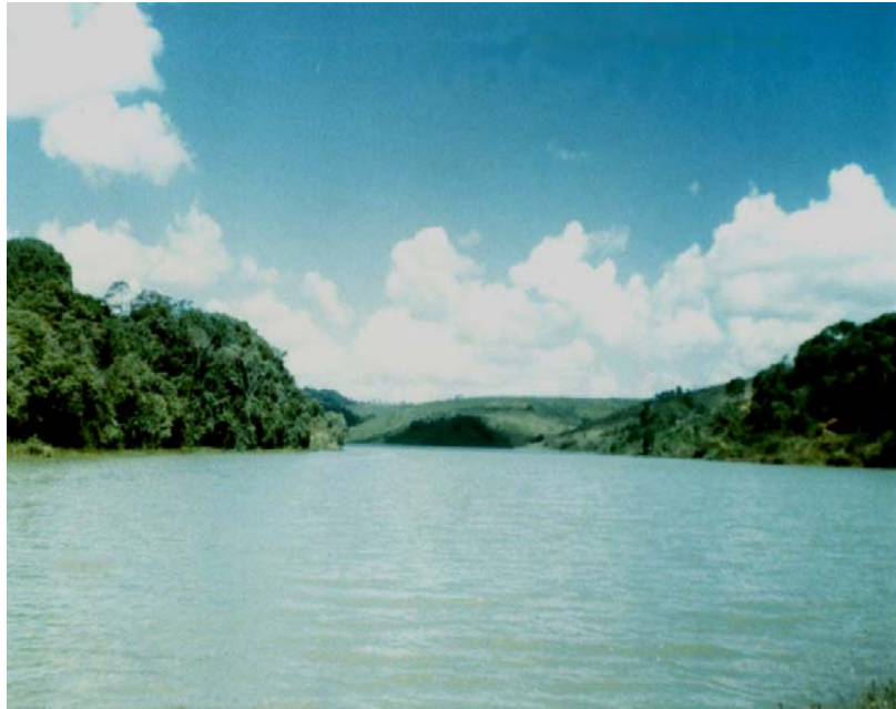
Figura 20 – Vista parcial da Barragem Brejão.
