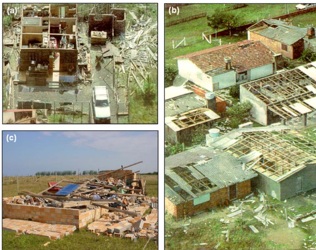
Figura 6 – Danos causados pelos fortes ventos do Furacão Catarina: a) telhados destruídos; b) destelhamentos generalizados; c) destruição total de casas.
