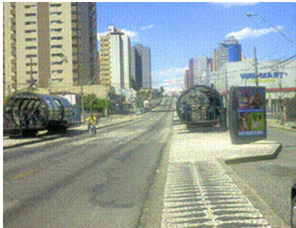
Figura 11 - Pavimento de concreto nas proximidades das estações tubo
