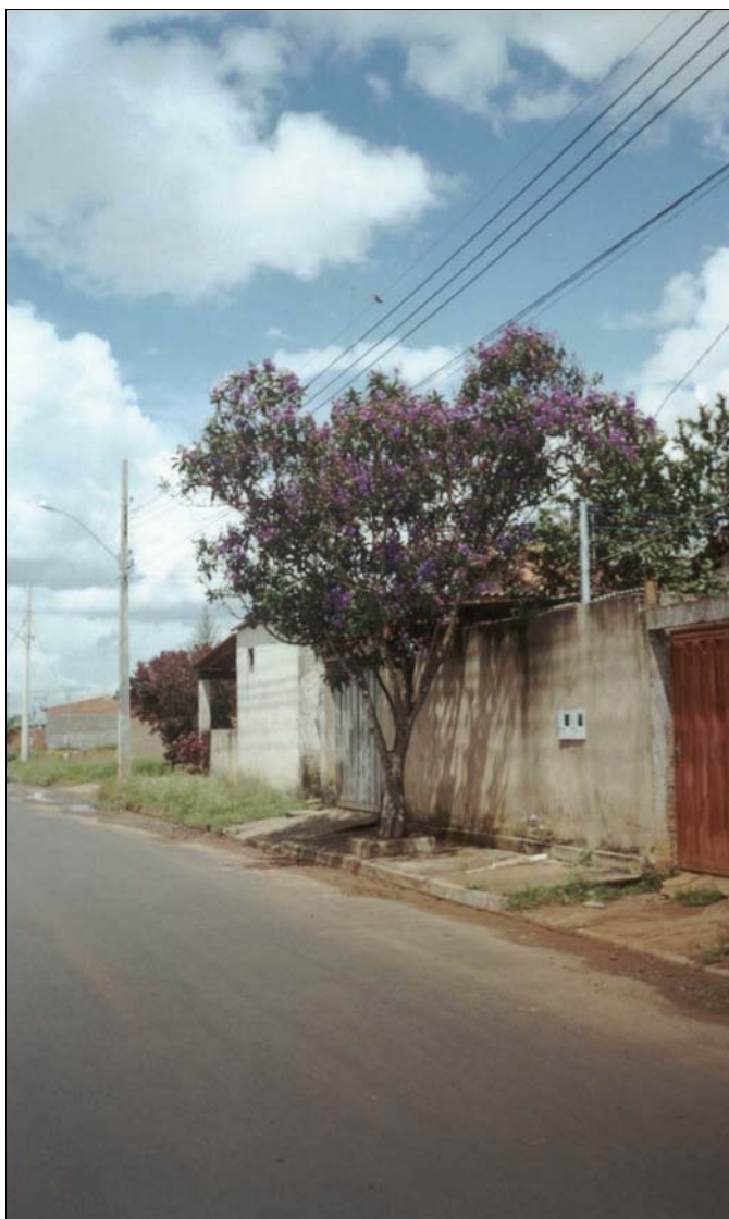
Figura 2 - conflito com a rede elétrica
