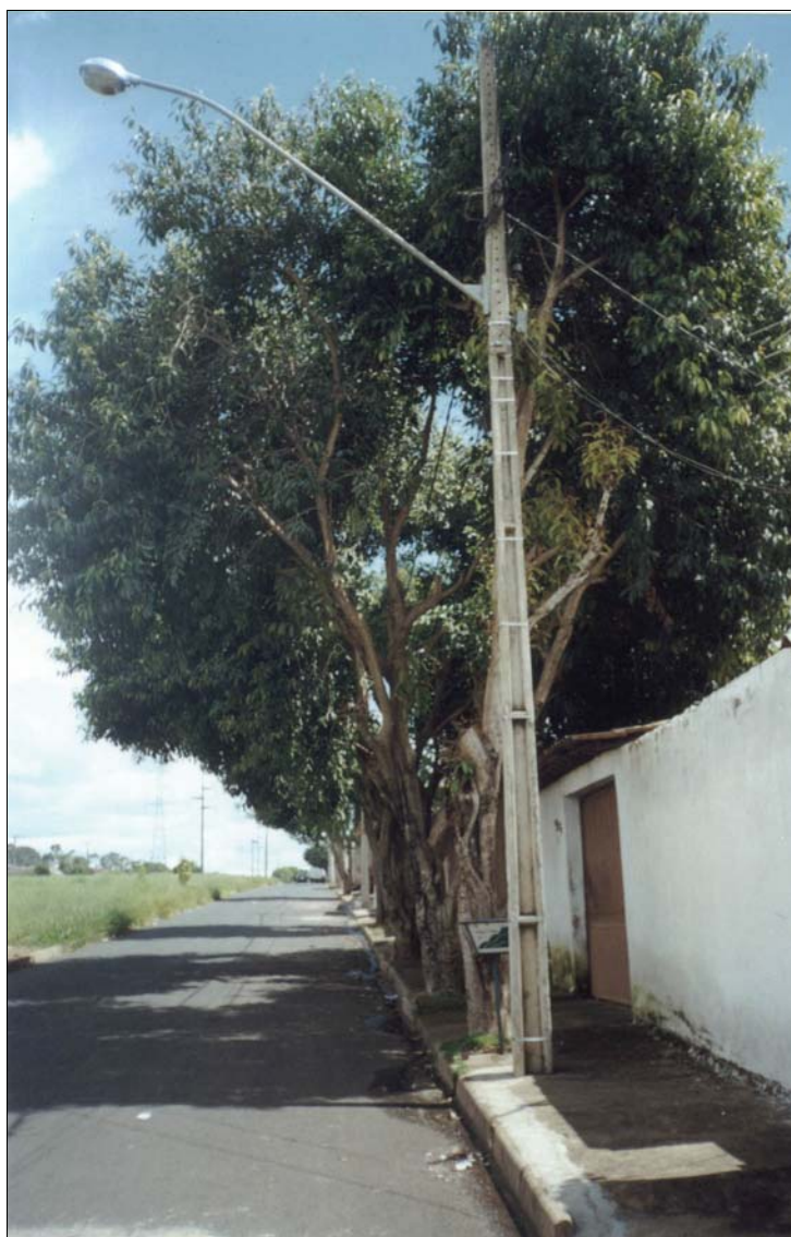
Figura 1 - conflito com a rede elétrica e passeio muito estrito
