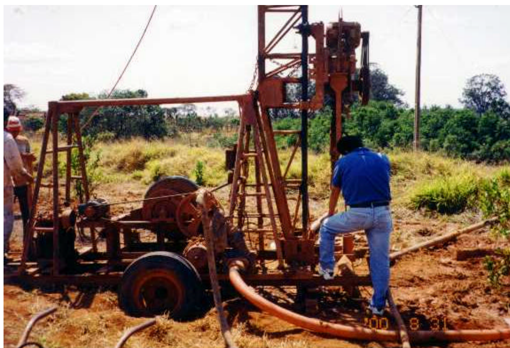
Foto 08 - Construção do Poço para coleta de água do lençol freático. Poço 04.
