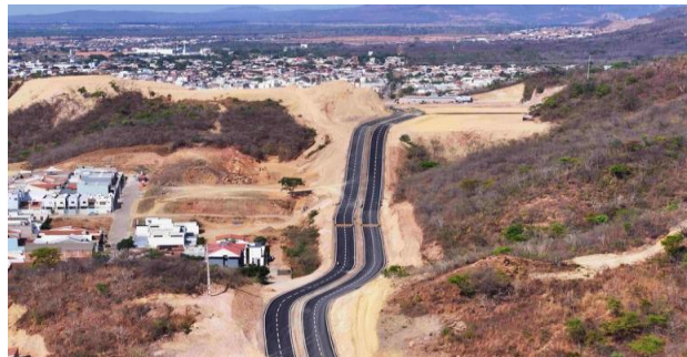
Figura 5 - Avenida Enock Ismael: trecho do rodoanel e intervenção de desmonte do relevo
