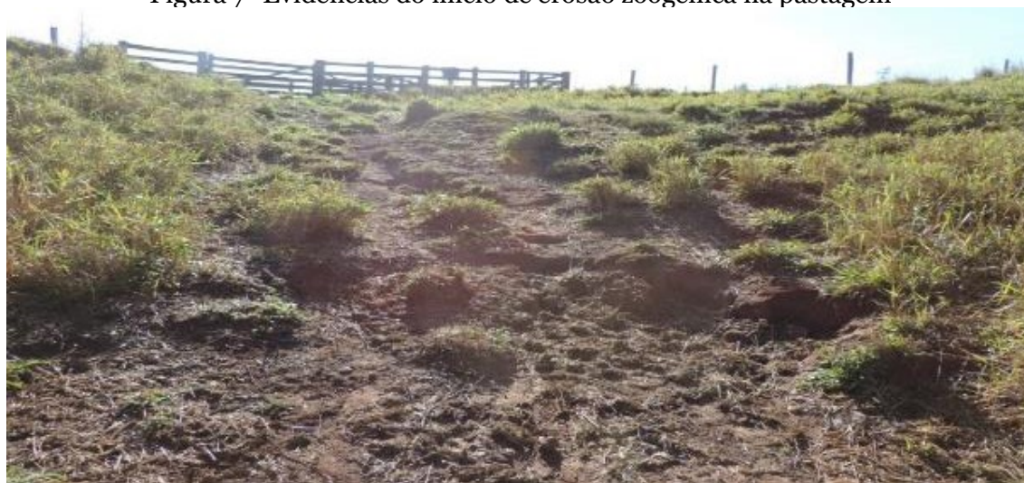
Figura 7- Evidências do início de erosão zoogênica na pastagem
