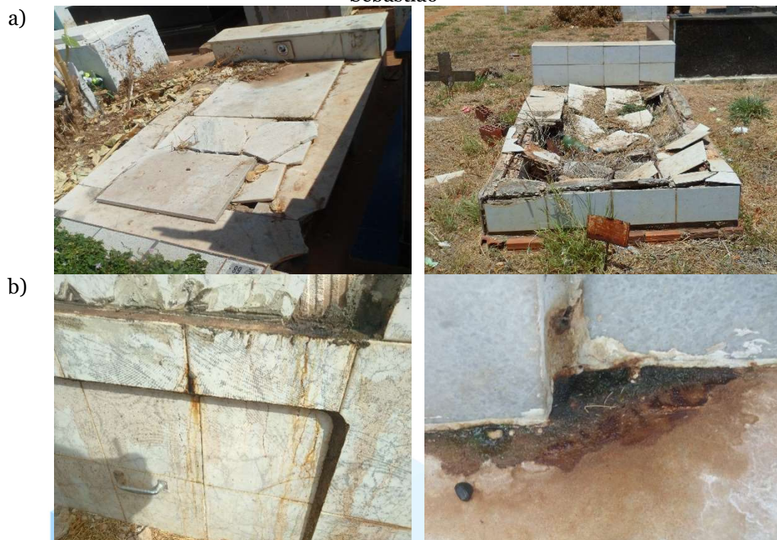
Figura 5 – a) Estado inadequado dos túmulos nos Cemitérios São Sebastião (à esquerda) e Novo Tempo (à direita). b) Extravasamento de necrochorume em túmulos no Cemitério São Sebastião
