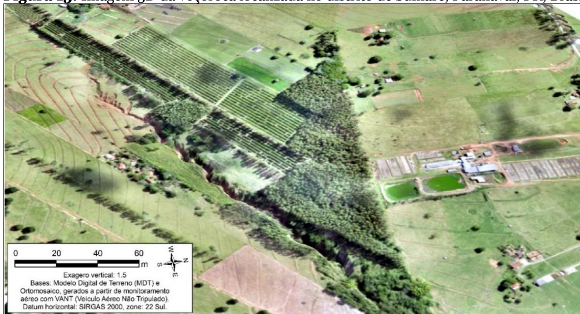
Figura 13: Imagem 3D da voçoroca localizada no distrito de Sumaré, Paranavaí, PR, Brasil
