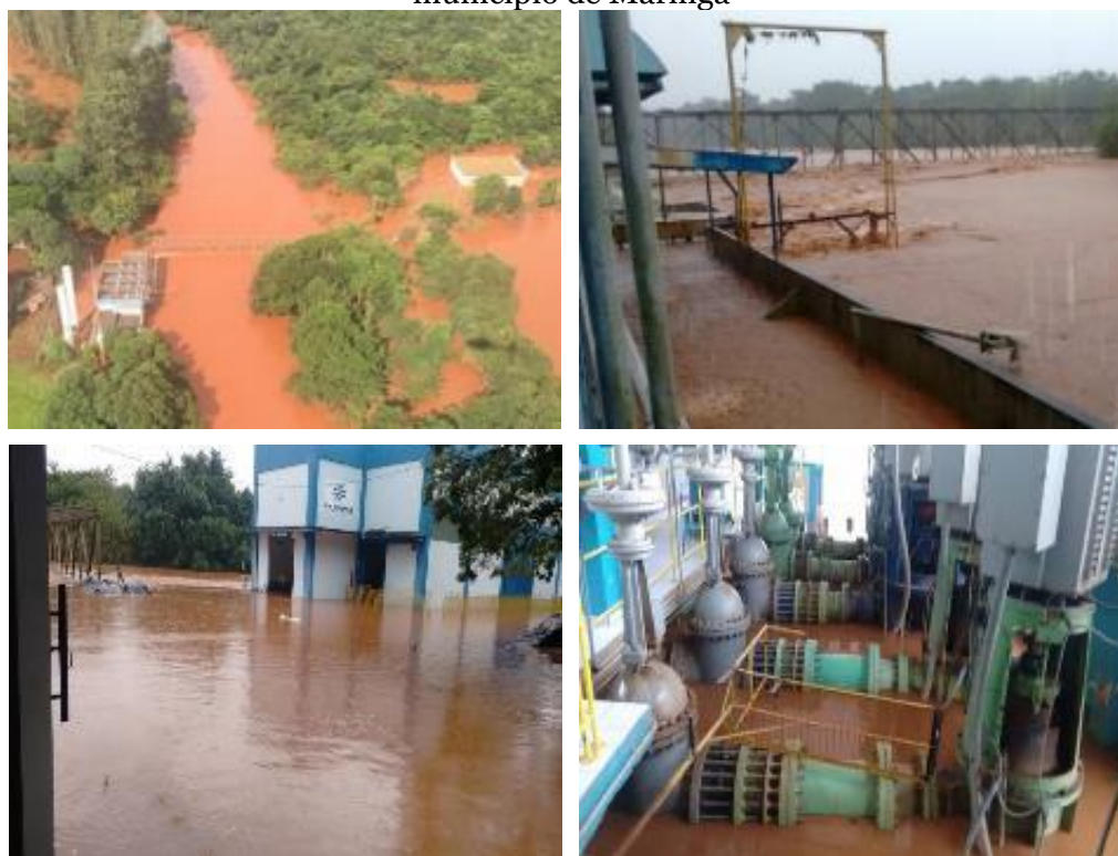
Figura 7: Área de captação e bombeamento da Sanepar completamente inundada no município de Maringá
