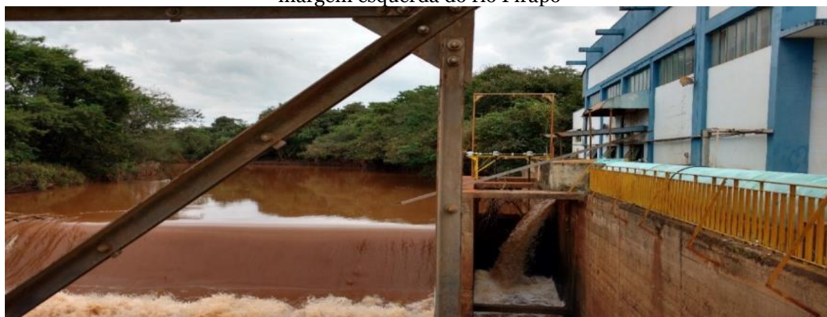
Figura 5: Localização do prédio com as bombas de recalque posicionada no talude da margem esquerda do rio Pirapó
