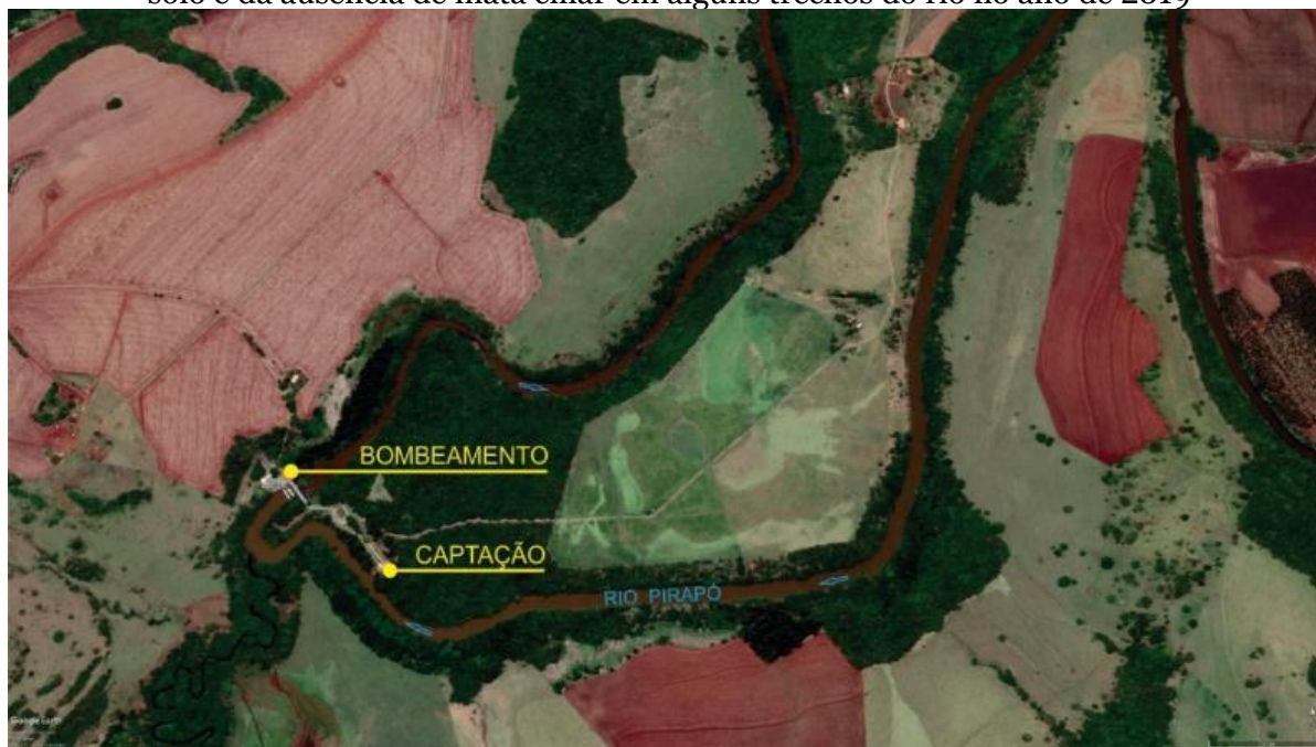
Figura 3: Vista aérea da área de captação e bombeamento da Sanepar, do intenso uso do solo e da ausência de mata ciliar em alguns trechos do rio no ano de 2019
