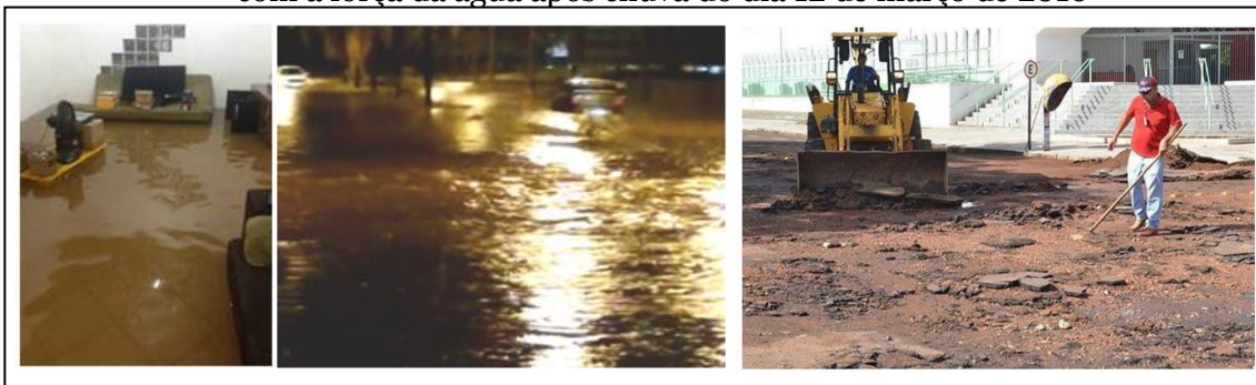
Figura 7 - Ruas alagadas, casas inundadas e asfalto de Avenida em Uberlândia-MG arrancado com a força da água após chuva do dia 12 de março de 2016
