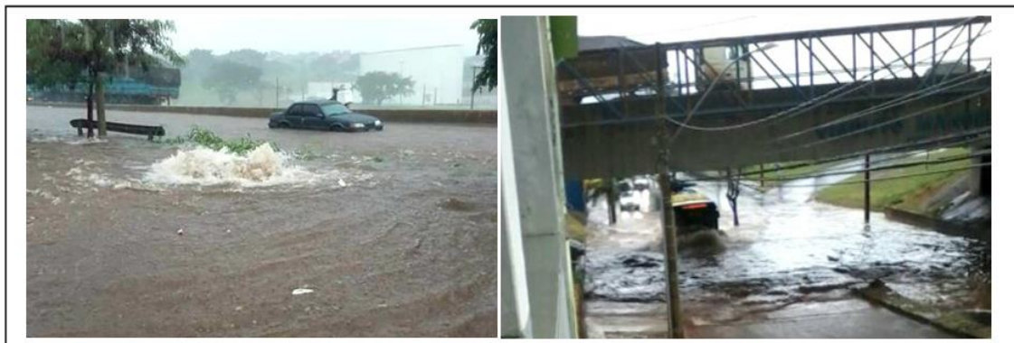
Figura 6 - Vias alagadas nos bairros Custódio e Brasil, setor leste da cidade após chuva do dia 03 de março em Uberlândia-MG
