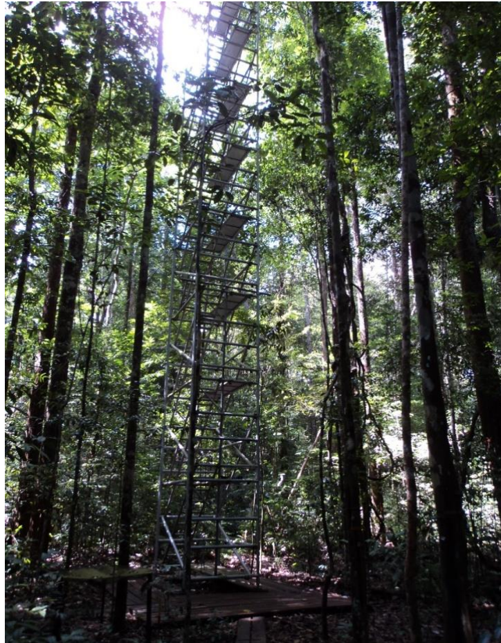
Figura 01 – Torre metálica utilizada na coleta dos dados meteorológicos na Floresta Nacional de Caxiuanã, Melgaço, Estado do Pará.
