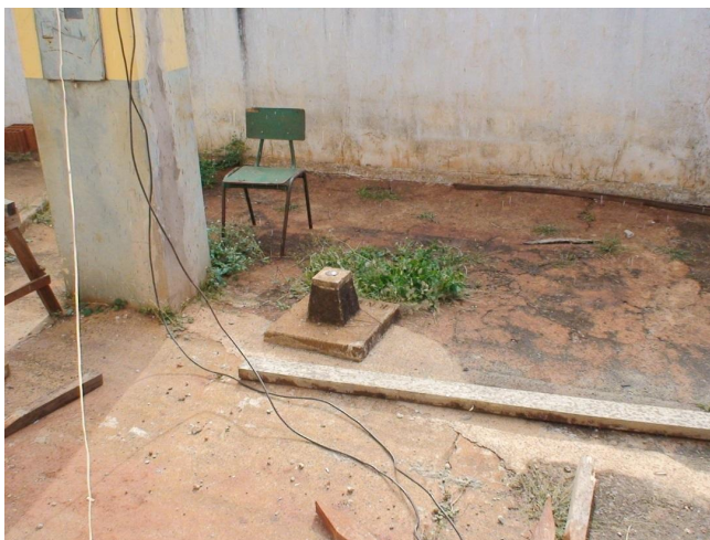
Foto 01: Estação RN 2171C e EG 8081031 (vista parcial).
