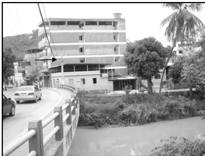
Figura 10 - Observa-se a ocupação das planícies de inundação do Rio Castelo, onde a seta indica a marca da última inundação que ocorreu no final de 2009.
