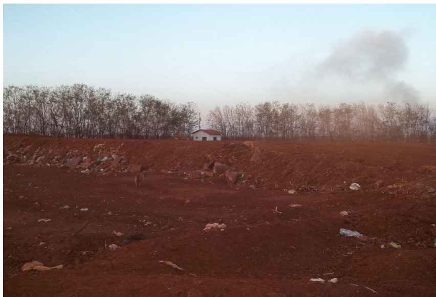
Figura 3: Camada de solo sobre os resíduos sólidos depositados no solo. Autor: LUIZ, L. M., agosto/ 2011
