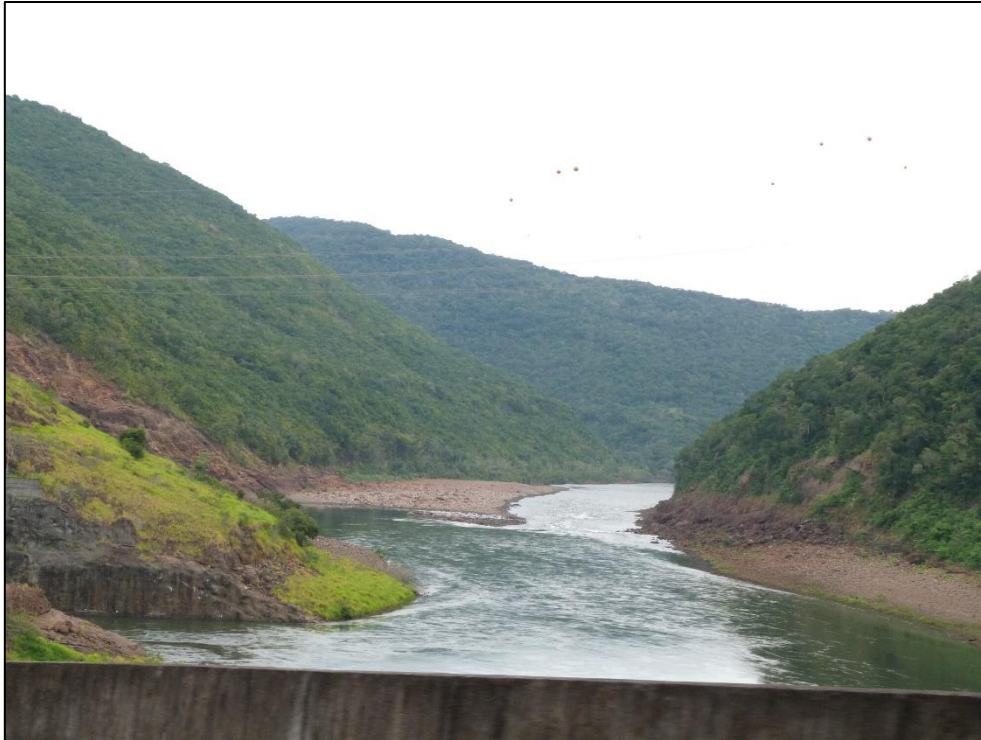
Figura 1. Usina hidrelétrica de Barra Grande, Anita Garibaldi, SC
