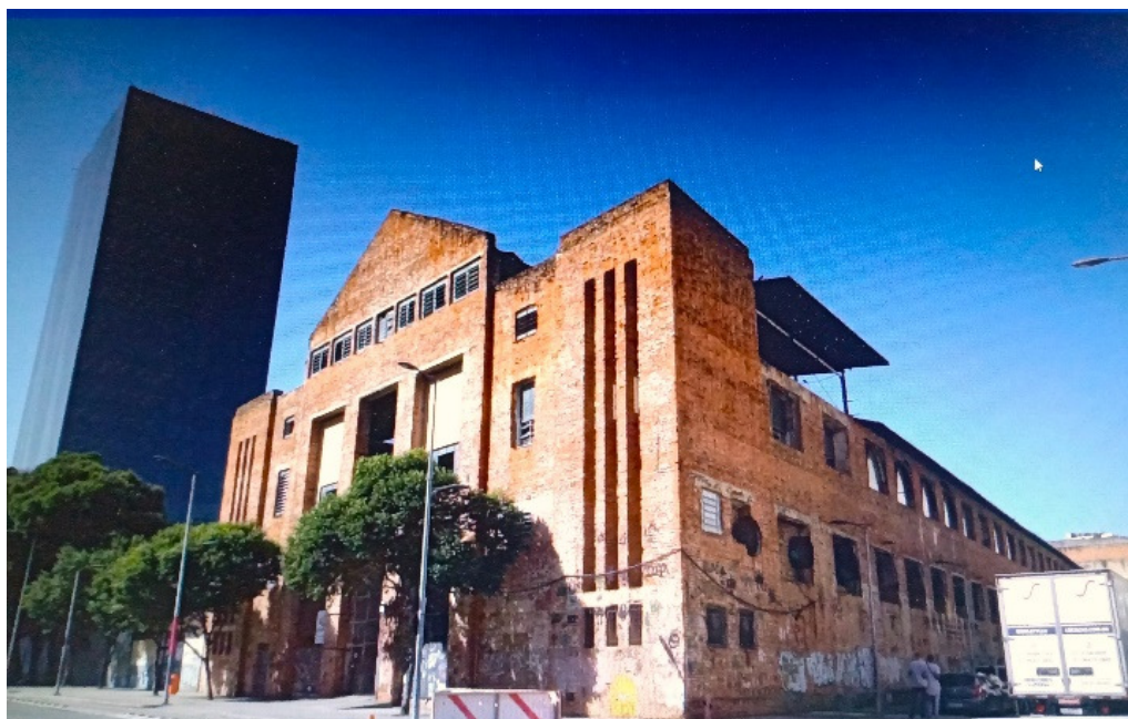
Figura 6. Galpão das Docas D. Pedro II. Área portuária do Rio de Janeiro-RJ, 2022.
