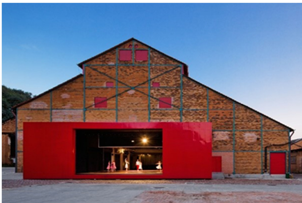
Figura 3. Teatro Erotildes de Campos. O galpão utilizado como teatro com a abertura do palco para o interior e exterior. Piracicaba-SP, 2012.
