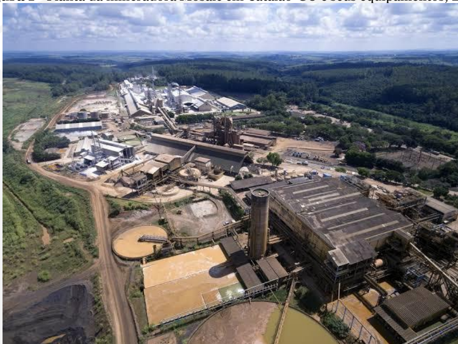
Figura 1 - Planta da mineradora Mosaic em Catalão-GO e seus equipamentos, 2024.
