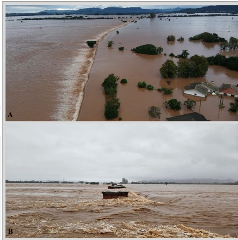
Figura 7. (A) Edificações parcialmente submersas nas proximidades da BR-348, em Dona Francisca e (B) Trecho da BR-348 destruído pela inundação.
