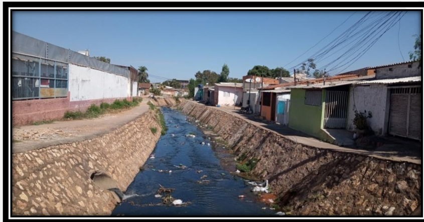
Figura 3 - Falta de rede coletora e tratamento do esgoto.
