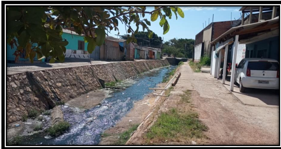
Figura 5: Canalização aberta sem cobertura vegetal
