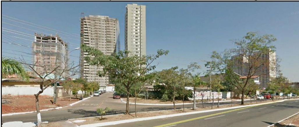
Figura 7: Prédios em construção na Rua Belo Horizonte, Bairro Parque Amazônia – Goiânia
