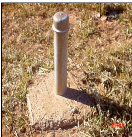
Figura 7 - Poço de Monitoramento de água subterrânea
