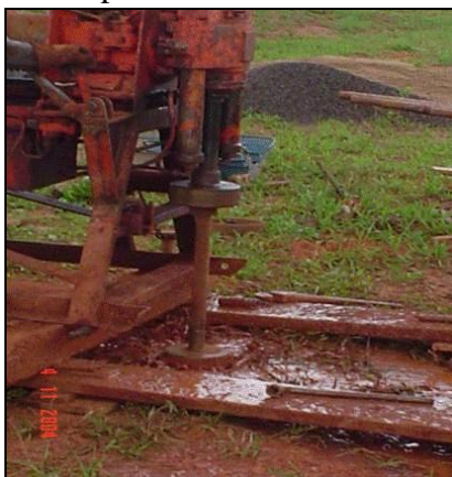
Figura 5 - Perfuração do solo com equipamento movido a ar comprimido
