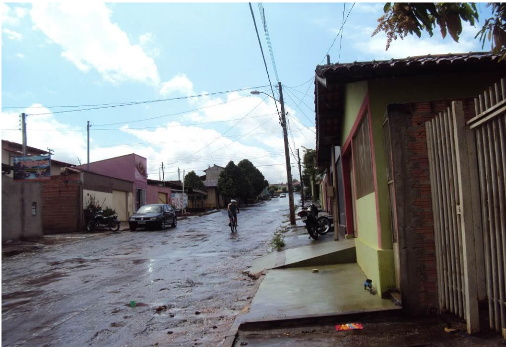
Fotografia 1: Calçadas desniveladas e estreitas.
