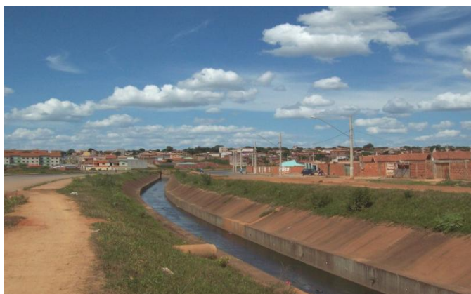
Foto04: Obras Paralisadas Na Avenida Doutor Alvimar. Autor: Souza, V. C. S., 2009.
