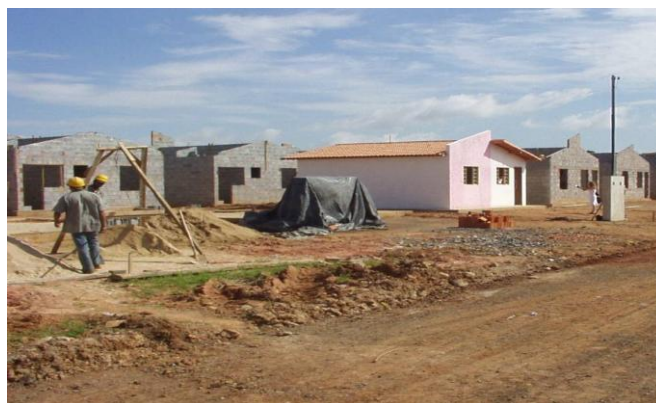
Foto 03: Unidades Habitacionais Na Construção Vila Vargem Grande. Fonte: Diretoria de Habitação Popular/SMPOLS/PMMC, 2006.
