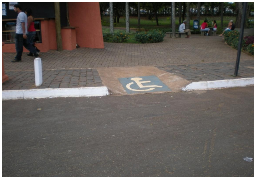
Figura 05: Parque do Sabiá, Rampa dentro das normas da ABNT, 2009.
