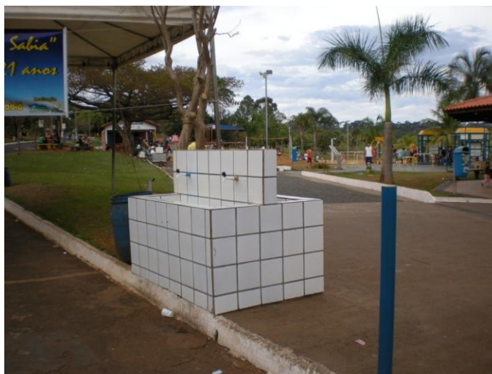
Figura 08: Parque do Sabiá; Bebedouro Inadequado para Cadeirante. 2009 Autor: SILVA, E. M. ago/2009
