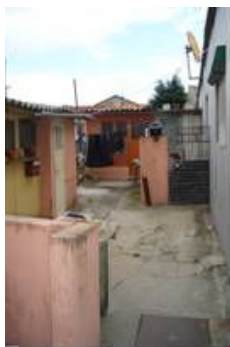
Figura 15 – R. da Preciosa casas dispostas à volta de pátio
