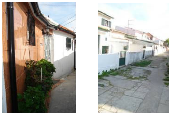
Figura 9 – Ilhas na R. João de Deus, onde se vêem obras de manutenção e construção de segundos pisos
