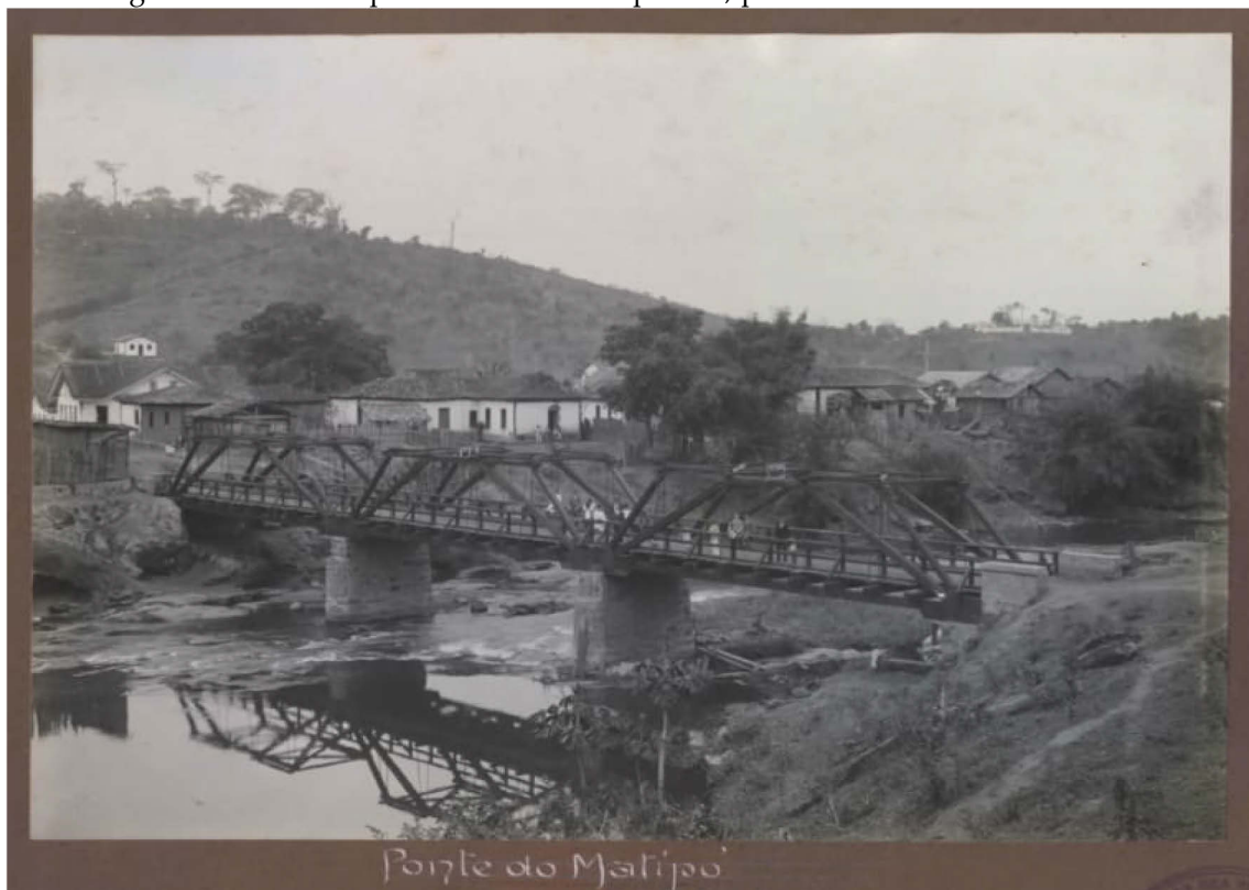
Figura 1 – Vista da ponte sobre rio Matipó-MG, por volta do início do século XX.
