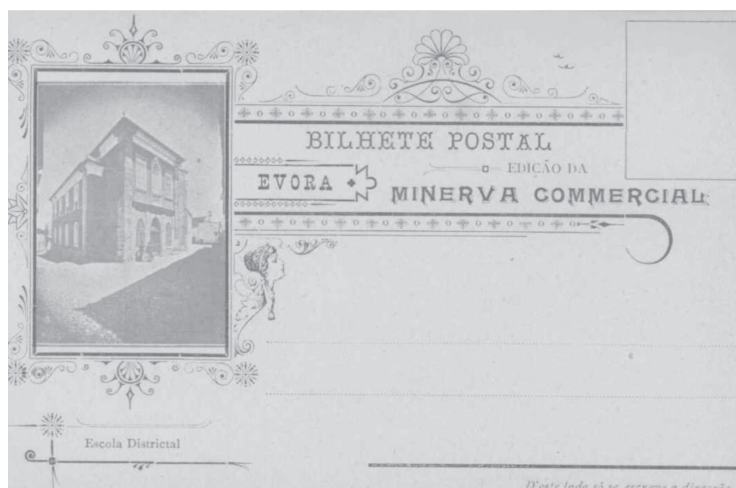
FIGURA 1 – Extinta Igreja Paroquial de S. Pedro onde funcionou a Escola Normal de Évora e depois a Escola Distrital
