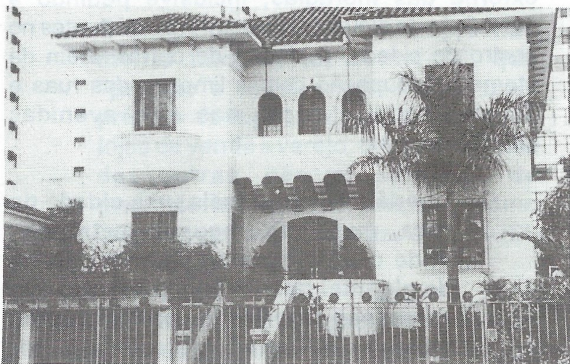
Casarão da Av. João Pinheiro
