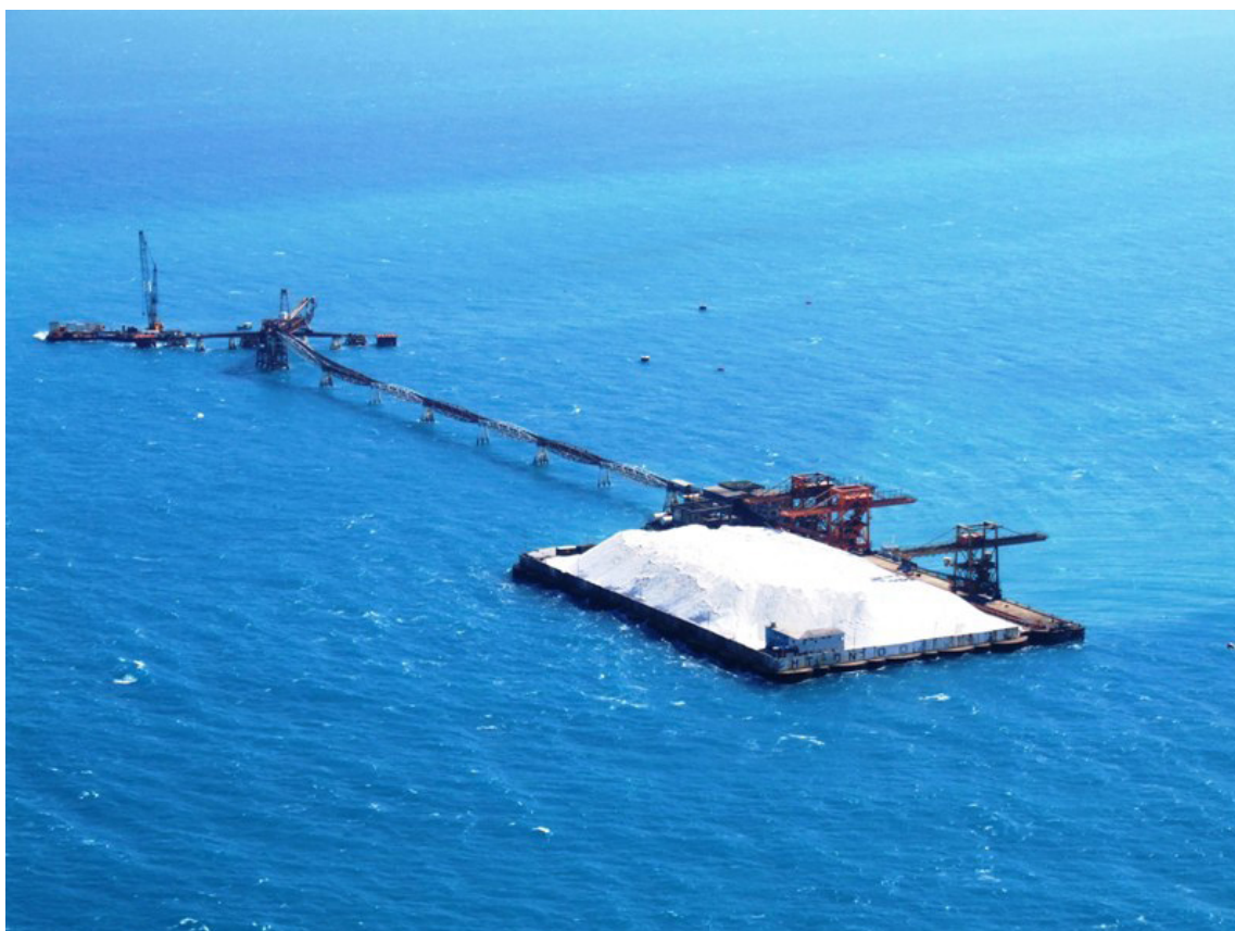
Figura 1 - Vista área e panorâmica do Porto-Ilha de Areia Branca
