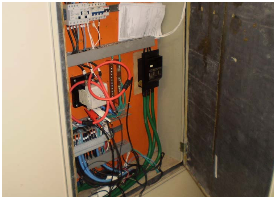
Figura 12 – Conexão do qualímetro no quadro elétrico do tomógrafo convencional.
